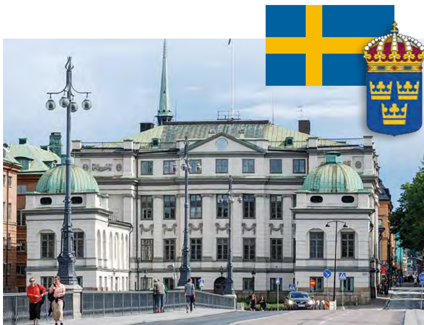
Палац Бондего — будівля Верховного суду Королівства Швеція у м. Стокгольмі.
